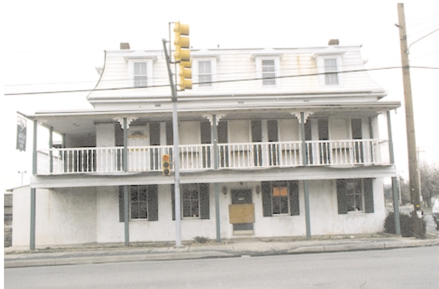
East, Front Facade (KAA:96-4) 3/96
